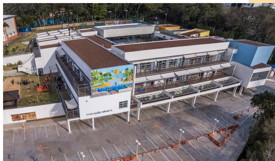
Fachada do prédio da Educação Infantil
