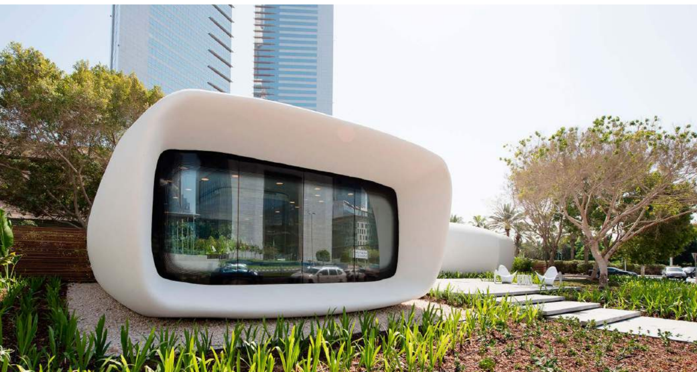
Edifício que abriga o Escritório do Futuro, em Dubai, foi construído a partir de uma impressora 3D
