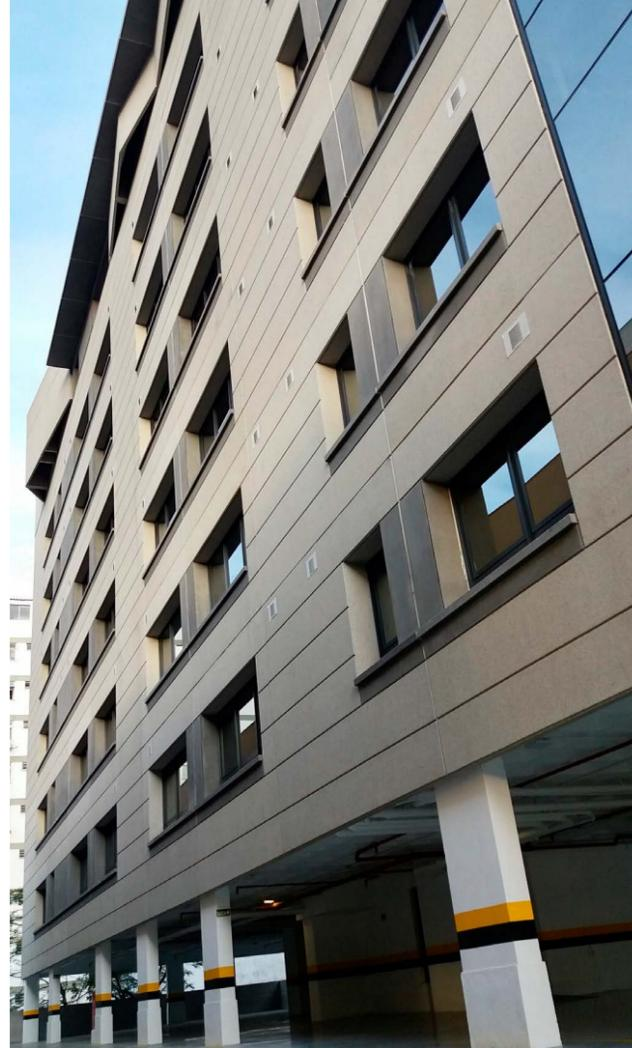
Com a conclusão de cada pavimento de painéis arquitetônicos, iniciou-se a instalação das esquadrias e do sistema de pele de vidro, ambos com a utilização de vidros com controle solar. Um elemento importante foi a contratação da simulação termoenergética, que mesmo não sendo exigência normativa para esta edificação, dotou o projetista de esquadrias e de vidros de informações essenciais e precisas para a otimização e racionalização na especificação do sistema "esquadria+vidros".
