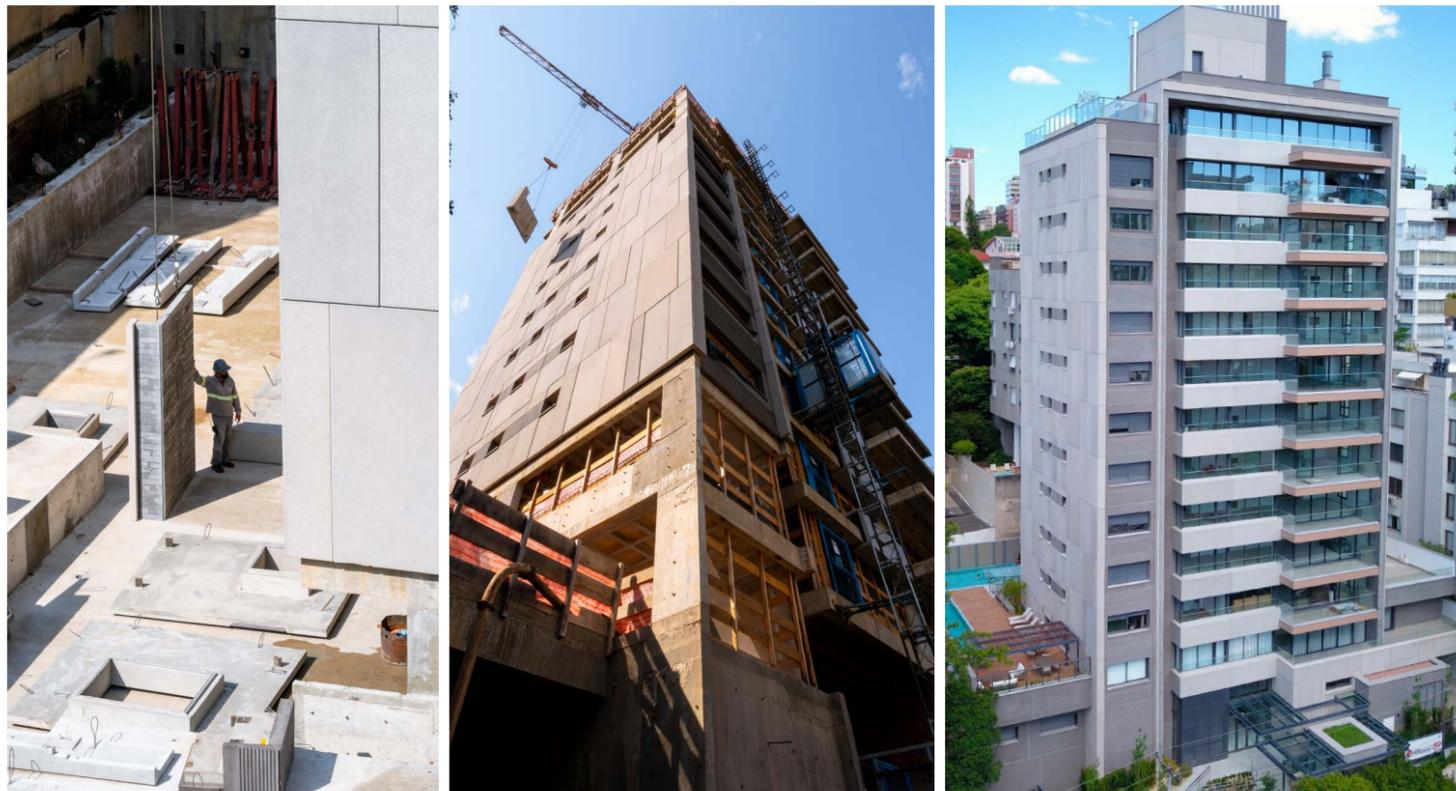
Os painéis arquitetônicos entregam velocidade de montagem, segurança, qualidade e personalização, além garantirem um conforto termoacústico superior, se comparado a uma fachada tradicional, reduzindo o consumo energético para a climatização dos ambientes
